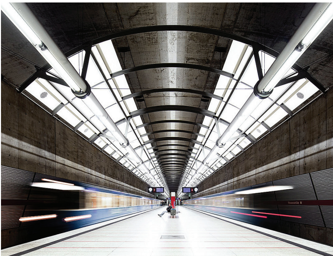
Рисунок 6. Освещение станции метро Messestadt Ost в Мюнхене
