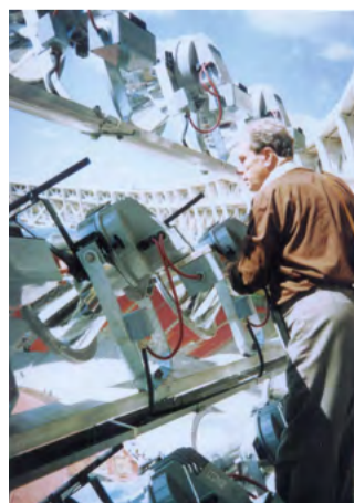
Юстировка прожекторов освещения спортивного стадиона в Лужниках, 1979г.
