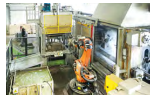
Роботизированный литейный комплекс, 2019 г.
