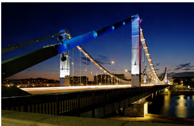
Крымский мост, осветительная установка 2006 г.
