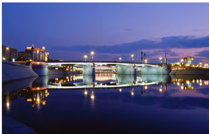
Бородинский мост, осветительная установка 2003 г.
