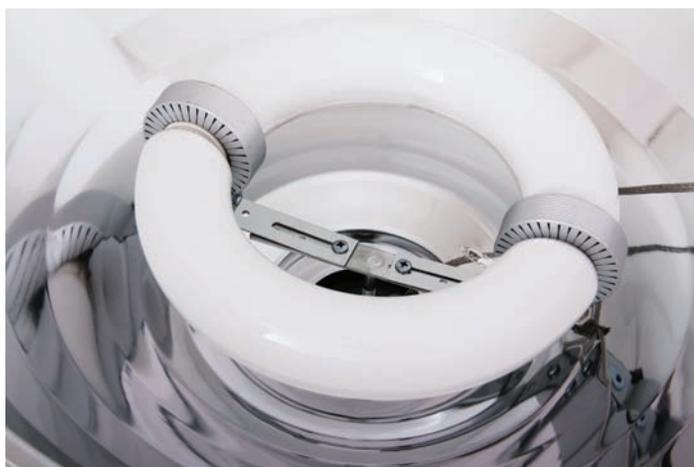
Для освещения цеха предложено 70 светильников с безэлектродными индукционными люминесцентными лампами мощностью 160 Вт.
