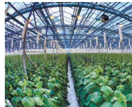
Пример освещения тепличного комплекса
