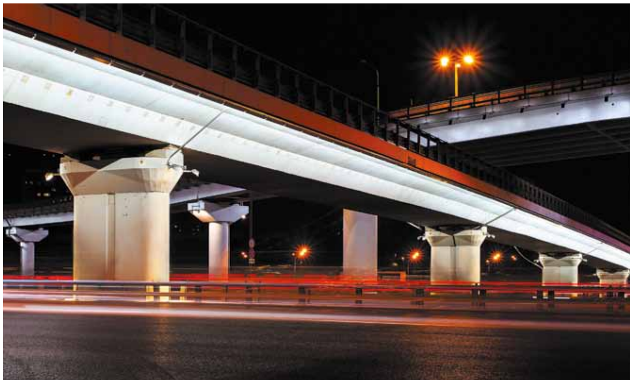
Рис. 1. Пересечение эстакады «Химки – МКАД» с эстакадой «Ленинградское шоссе – внешняя сторона МКАД»
