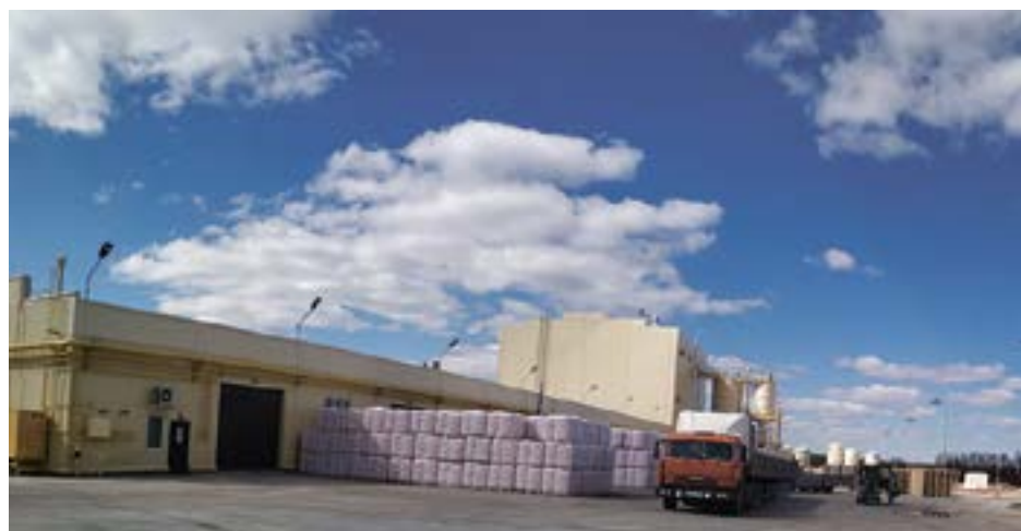
Светильники GALAD на территории Звениговского завода строительного гипса
